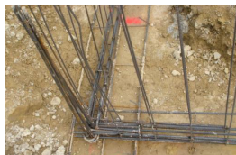
Noeud de chaînage - Continuité mécanique
