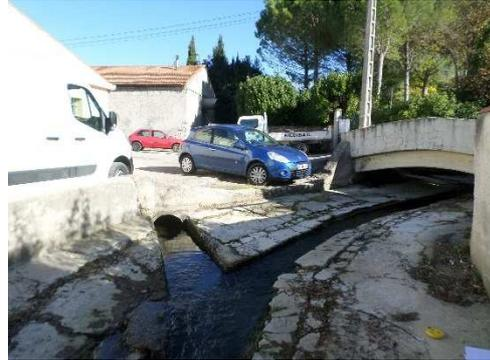
Figure 20 : Débouché du réseau busé au niveau de la Salle des fêtes – mauvaise évacuation des eaux
