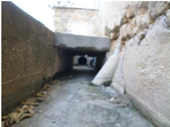
Figure 53 : Fossé bétonné en aval du réseau enterré - Popian
