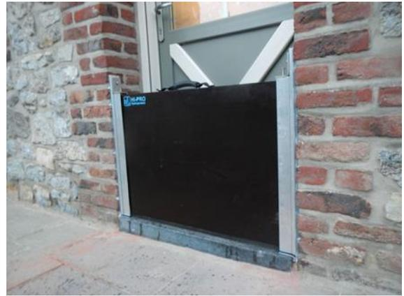
Figure 58 : Exemple de batardeaux
