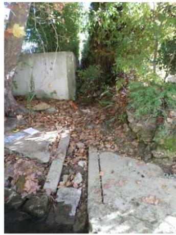
Figure 41 : Ruisseau bouché au niveau du tronçon entre les ponts 2- 3
