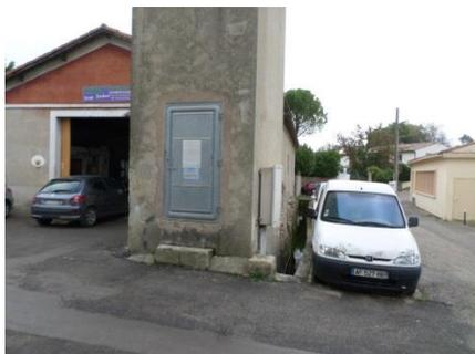
Figure 12 : Fin du réseau enterré – Début fossé bétonné
