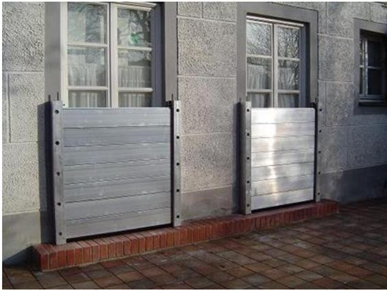
Figure 57 : Exemple de batardeaux
