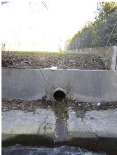
Figure 59 : Exutoire pluvial dans le ruisseau de l'Aurette
