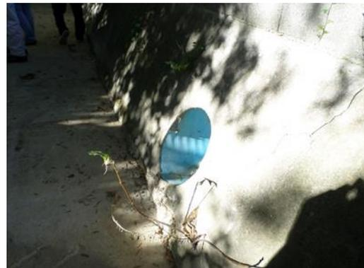
Figure 60 : Exutoire pluvial dans le ruisseau de l'Aurette
