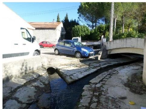
Figure 49 : Débouché du réseau busé au niveau de la Salle des fêtes – mauvaise évacuation des eaux
